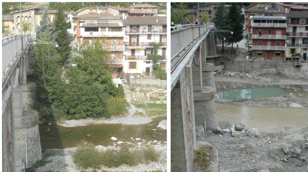
Figura 45: Sezione idrometrica di Farini prima (ottobre 2012) e dopo il passaggio della piena (settembre 2015)
