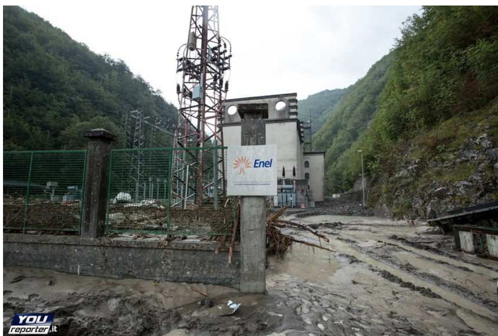
Figura 18: Allagamento del piazzale antistante le centrale Enel di Ruffinati.
