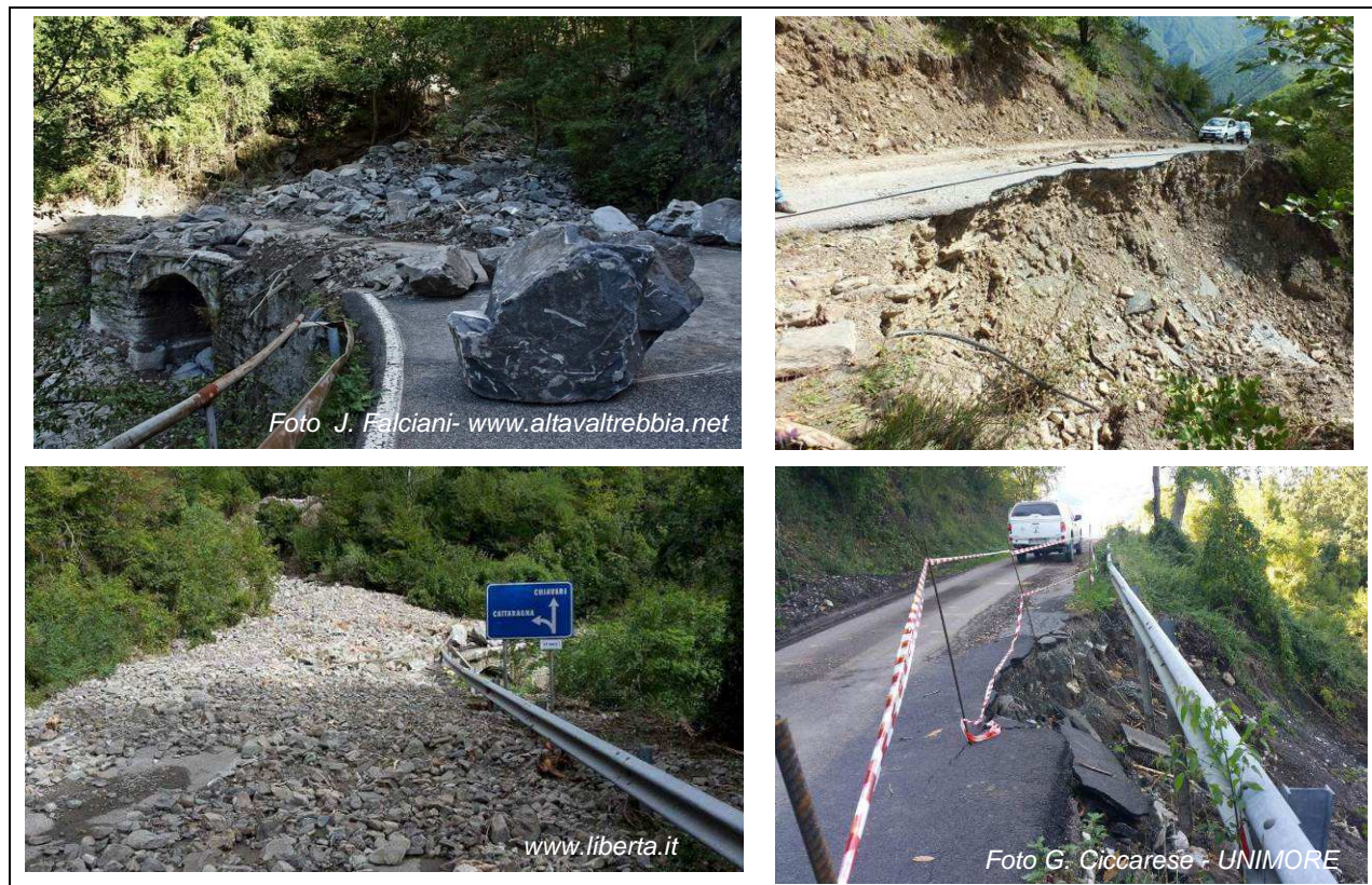
Figura 20: danni alle strade nel Bacino del torrente Aveto provocate da fenomeni di frana, di erosione e di accumulo di sedimenti esondati dall'alveo dei torrenti e rii.
