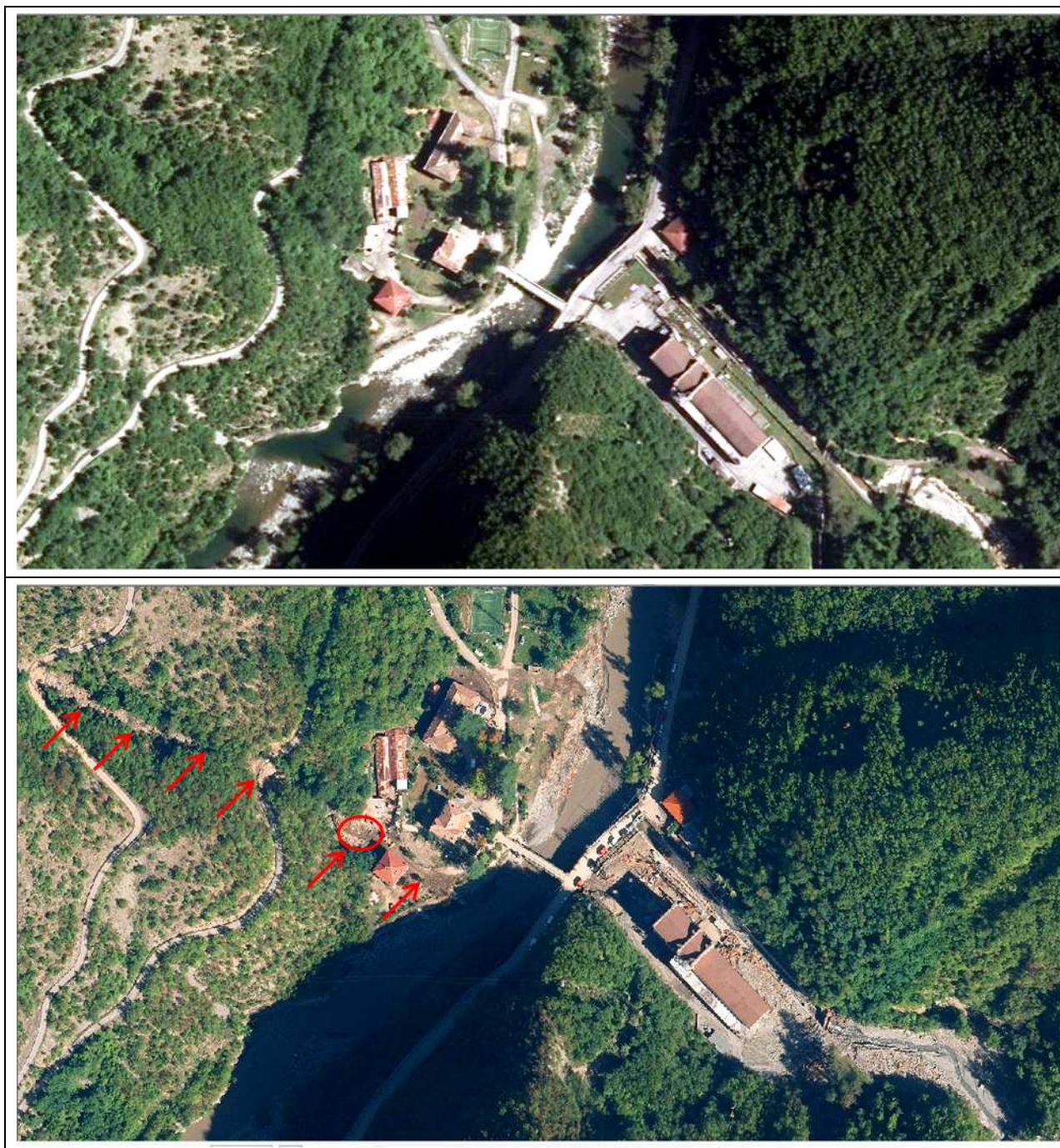
Figura 19: L'area di confluenza tra il Rio Ruffinati (a destra) e il Torrente Aveto prima dell'evento (in alto) e dopo l'evento (in basso). Si nota il diffuso sovralluvionamento subito dall'alveo del torrente in prossimità della centrale ENEL ( in basso a Destra). In alto sinistra è visibile la traccia di una colata detritica che ha distrutto due tratti della strada per la località Lisore e un manufatto (cerchio rosso) sfiorando un edificio abitato, prima di riversarsi nel torrente Aveto.
