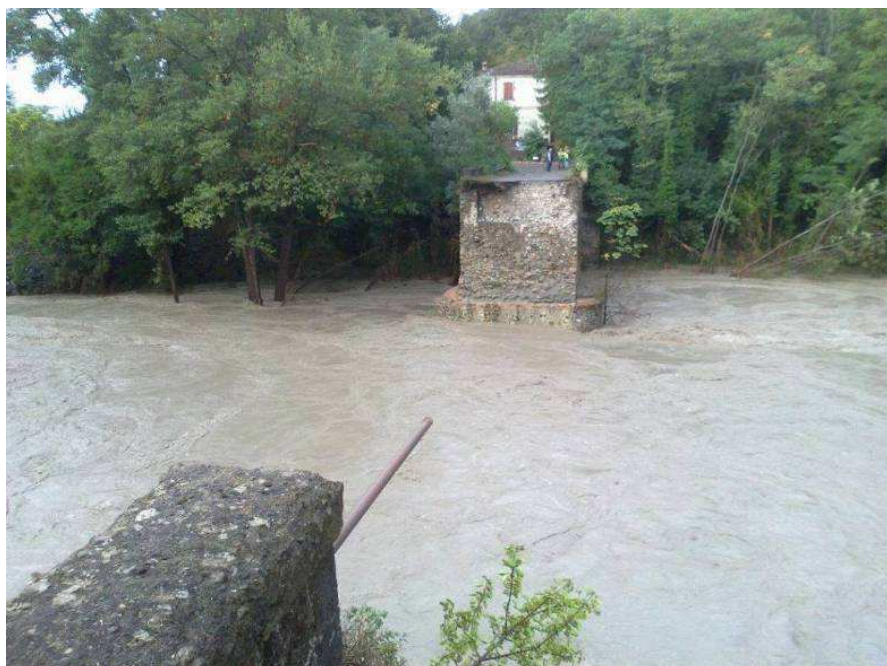
Figura 25: Crollo del ponte storico di Barberino, a valle di Bobbio
