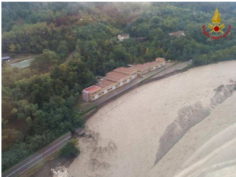
Figura 36: Foto aerea del tratto viario della SP 654 distrutta dalla piena a Bettola.
