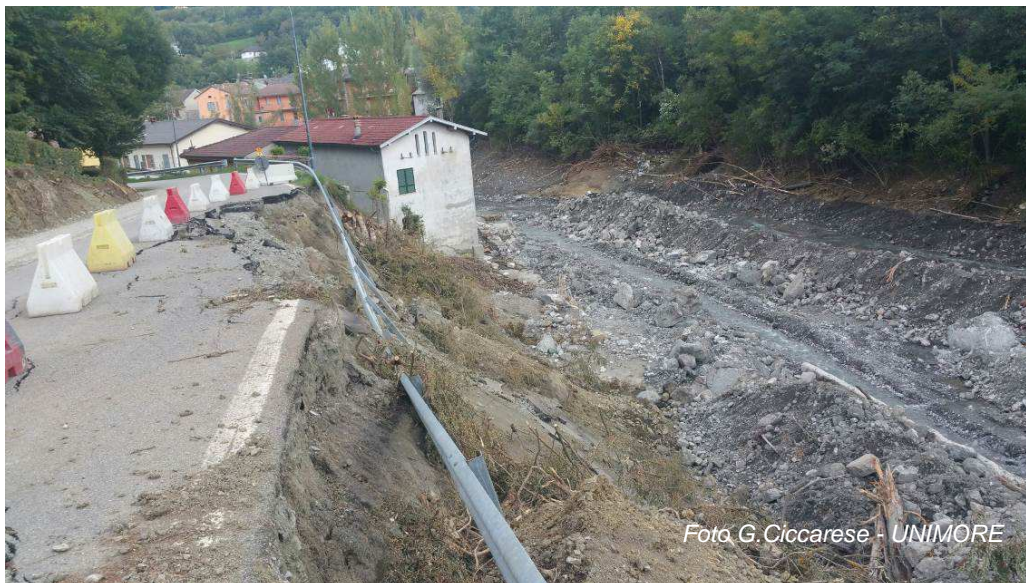
Figura 30: Rio Grondana immediatamente a monte dell'abitato di Ferriere. In primo piano la strada Provinciale del Passo del Mercatello danneggiata dalla piena.
