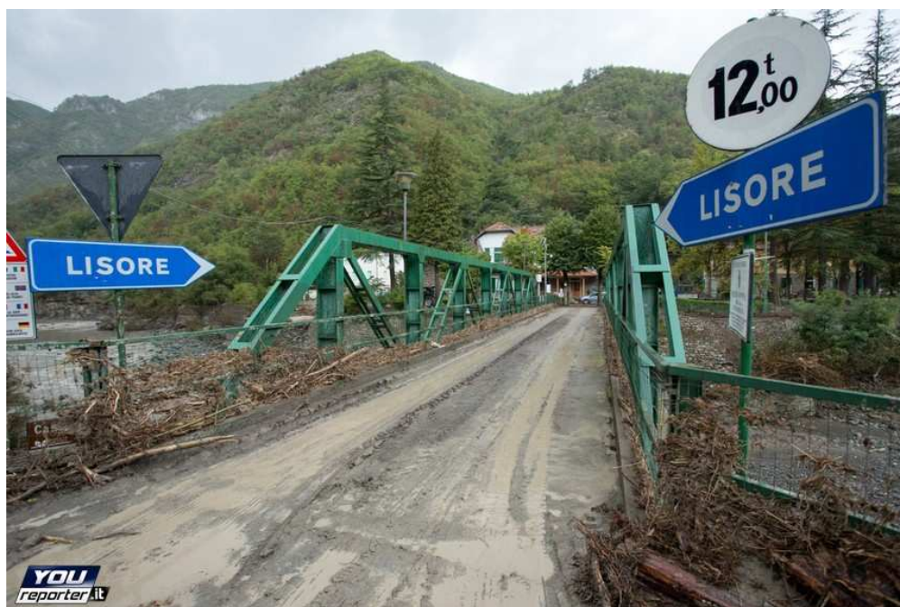
Figura 17: Ponte in corrispondenza della sezione teleidrometrica di Salsominore, dopo il sormonto della piena.
