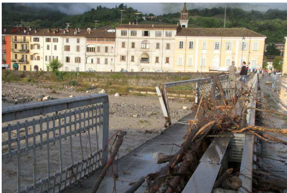
Figura 37: Il ponte sul Nure a Bettola, danneggiato dalla piena ( www.liberta.it ).
