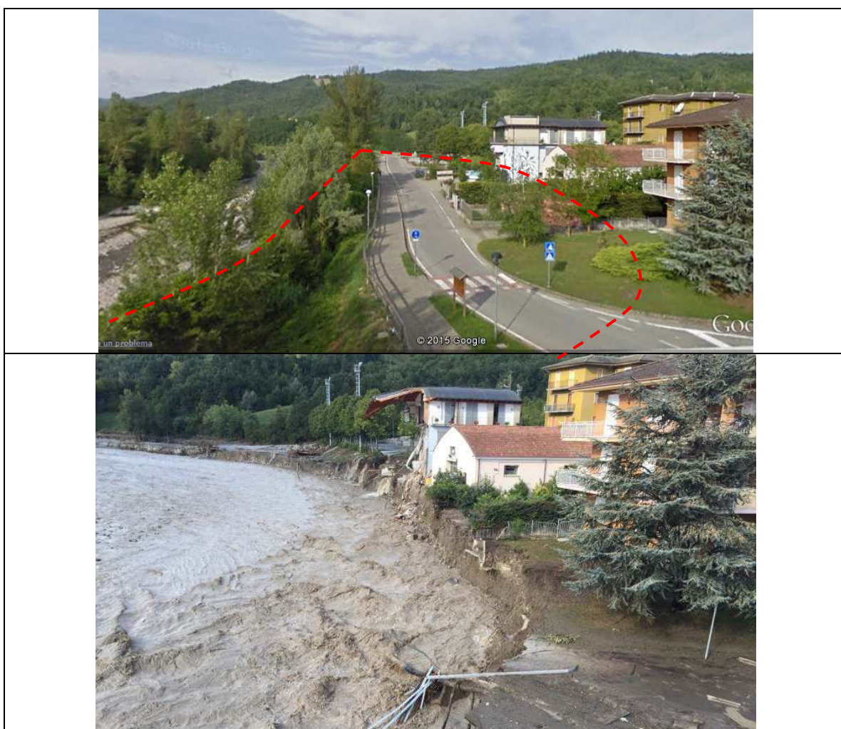
Figura 35: Strada comunale Alta Val Nure in corrispondenza del centro abitato di Farini, prima (da https://maps.google.it ) e dopo la piena con evidenziata in rosso uno dei tratti asportati dalla corrente.
