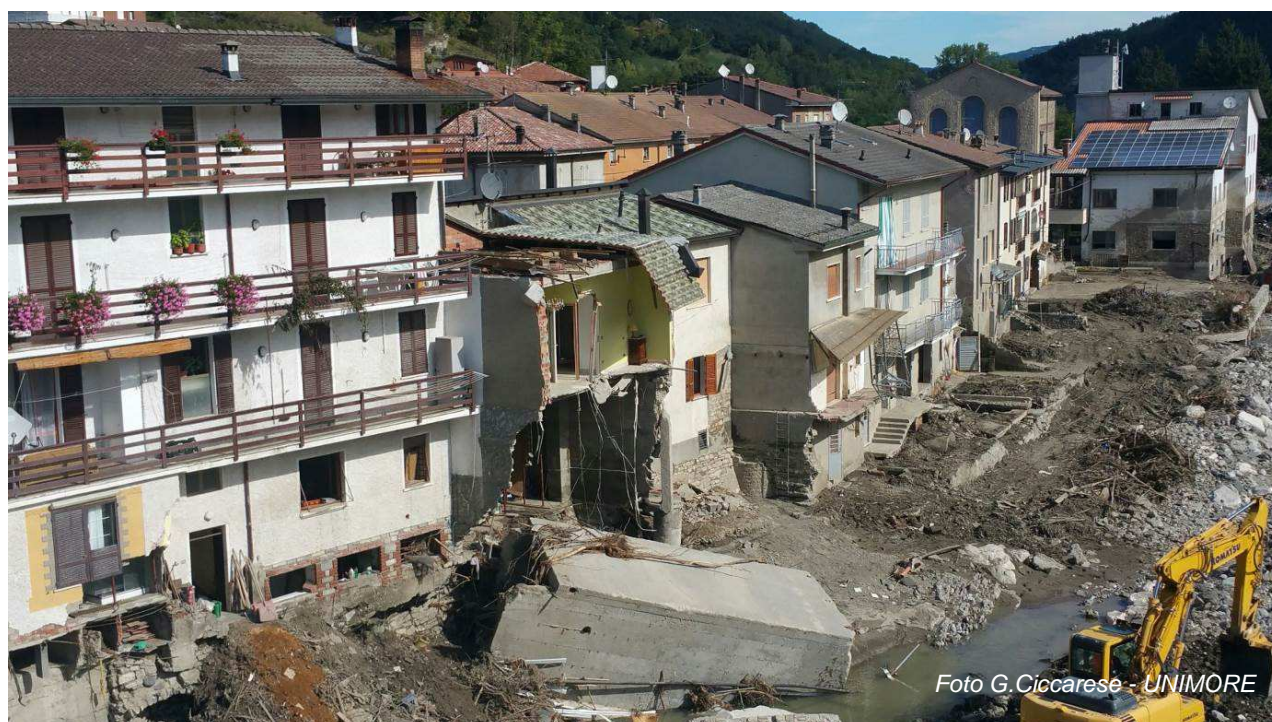
Figura 33: Le case dell'abitato di Farini, investite dalla piena del Nure. Si notano le abitazioni e le difese spondali parzialmente distrutte e in primo piano lo scatolare dell'attraversamento di un torrente in sinistra della strada comunale Alta val Nure, trascinato a valle.
