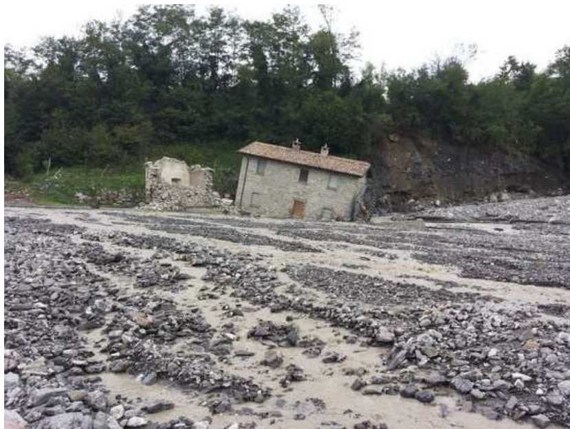
Figura 29: Molino di Pomarolo, irrimediabilmente danneggiato, a monte dell'abitato di Ferriere alla confluenza tra il Torrente Grondana e il Rio Ricco ( www.altavaltrebbia.net ).
